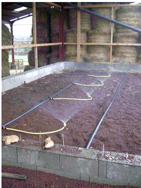
Photo 9 : Rampes et asperseurs – Station béton
