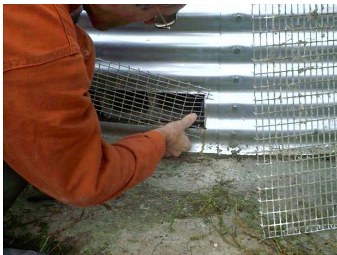
Photo 15 : Grillage devant les ouvertures – Station Silo
