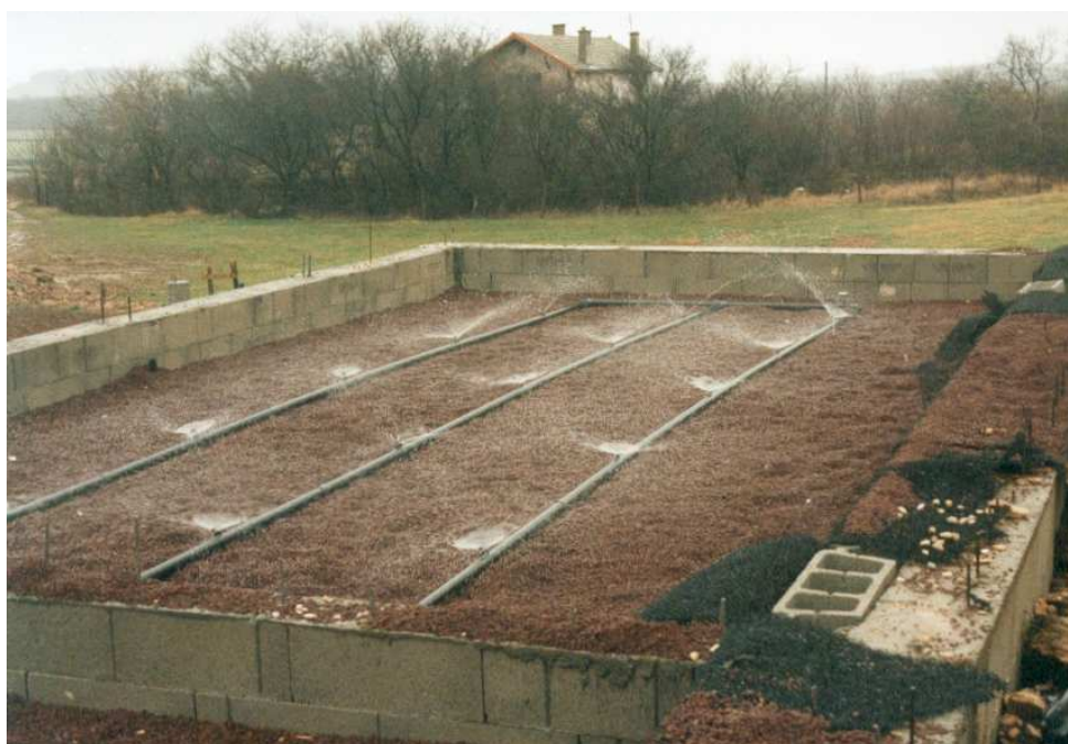
Photo 11 : Rampes et diffuseurs – Station béton
