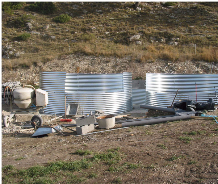
Photo 14 : Montage des plaques – Station Silo
