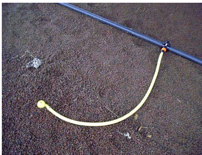
Photo 10 : Rampes et asperseurs type soucoupe avec tuyau flexible – Station béton
