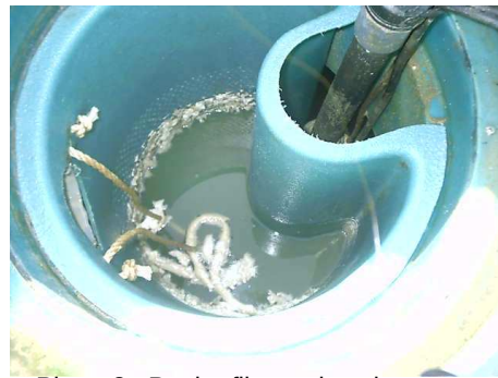
Photo 2 : Panier filtrant dans la cuve
