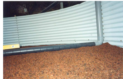
Photo 7 : Disposition des drains
