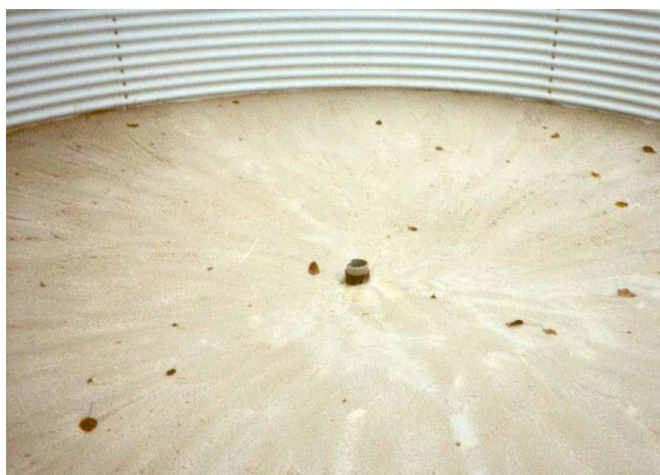
Photo 12 : Récupération du filtrat par trou central – Station Silo
