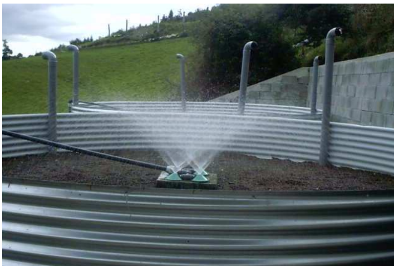
Photo 18 : Vue des 4 asperseurs de type « soucoupe »- Station Silo
