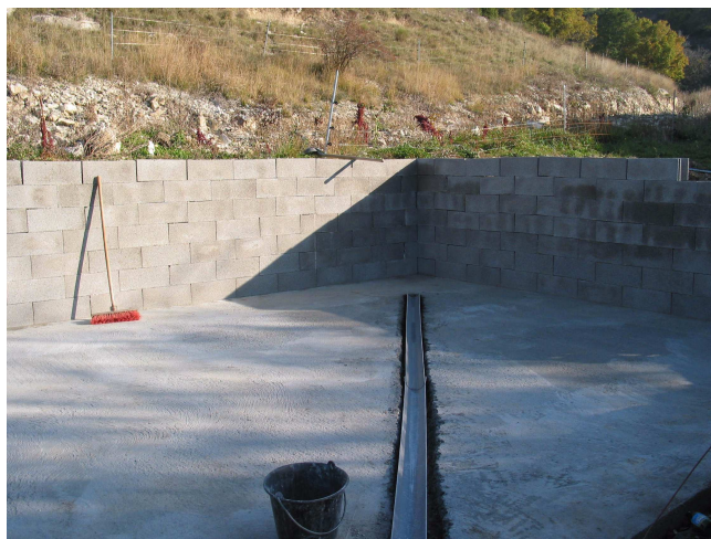
Photo 13 : Récupération du filtrat par gouttière – Station Silo
