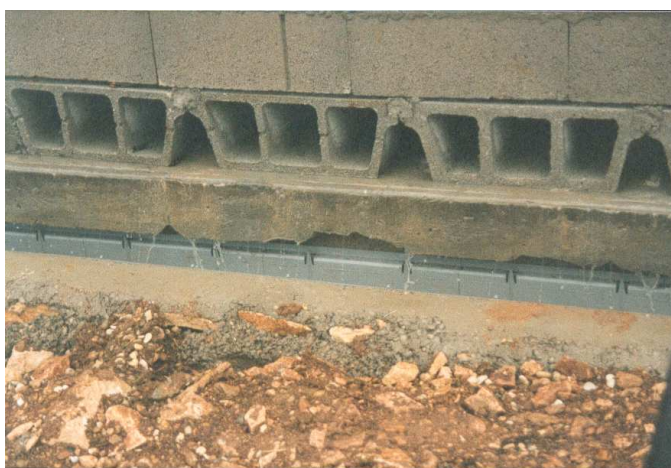
Photo 4 : Chenal de récupération du filtrat - Station Béton
